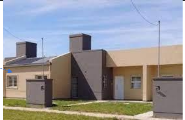
IMAGEN 8. Aleros insuficientes para la region bioclimatica- Viviendas en Bella Vista (Provincia de Corrientes)
