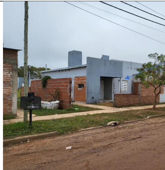
IMAGEN 8. Aleros insuficientes para la region bioclimatica- Viviendas en Bella Vista (Provincia de Corrientes)
