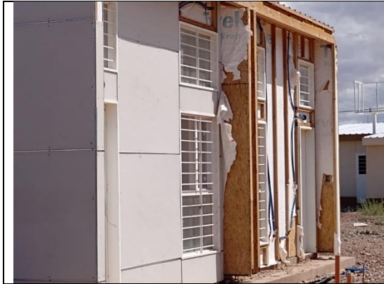
IMAGEN 7. Aleros insuficientes para la region bioclimatica- Viviendas en Santa Catalina- (ciudad de Corrientes)
